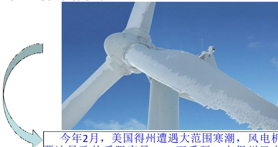
今年2月，美国得州遭遇大范围寒潮，风电机组因叶片覆冰导致的受阻容量1200万千瓦，占得州风电总装机的50%，成为引发大停电的重要原因，值得警惕！The cold wave in Texas aroused blackout due to the wind turbine froze and power lost reached to 12 GW.
